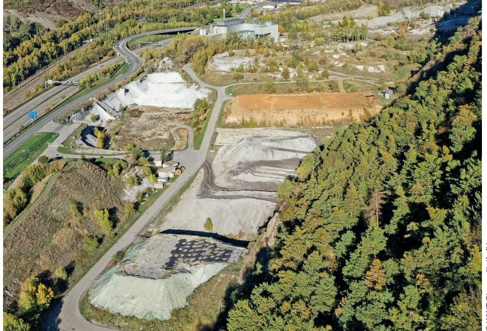
Bei grossen Dossiers wie der Sanierung von Gamsenried ist eine Zusammenarbeit wichtig.
