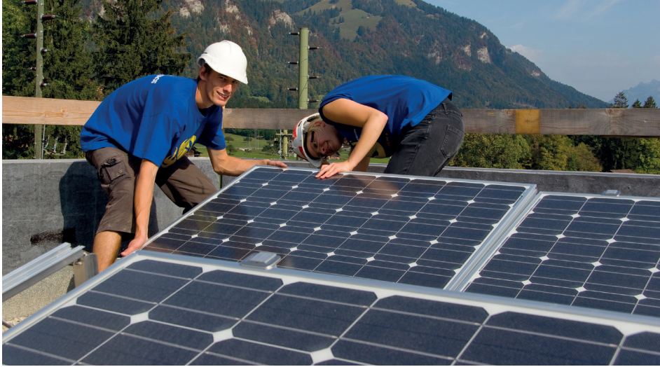
Montage einer Photovoltaik-Anlage auf einem Hausdach. Foto: Greenpeace
